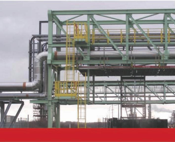
Es bestand die Forderung, dass die Rohrleitung dem Feuer bis zu 60 min standhält. Zusätzlich zu den Brandschutzforderungen musste auf Grund der hohen Temperaturdifferenz zwischen Transportmedium (flüssiges Ethylen bei  $-105^{\circ}\text{C}$ ) und der Umgebungstemperatur die Diffusionsdichtigkeit des Mantelrohres gewährleistet sein.
