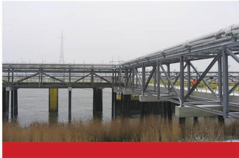
Zum Einsatz kam ein Doppelmantelrohrsystem vom Typ FIRESAFE-T60, welches durch den Brandschutzschaum und dem Spiralfalzmantel die geforderten Eigenschaften besitzt. Die Rohrbrücken wurden bei diesem Projekt in Modulbauweise installiert. Das Jabitherm-System bietet auf Grund seines hohen Vorfabrikationslevels insbesondere bei dieser Bauweise entscheidende Vorteile.
